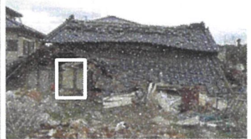
2011年東北地方太平洋沖地震災害調査速報 日本建築学会より
