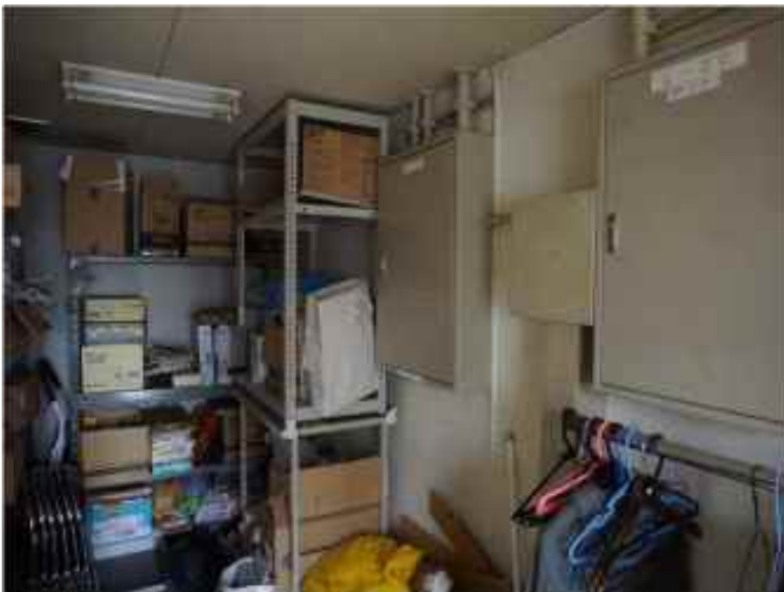
1F_サービスセンター_倉庫
