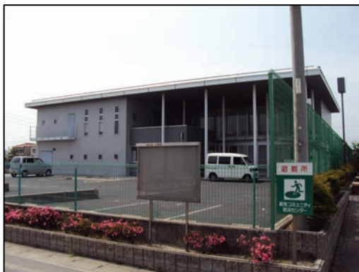
坂牧コミュニティ防災センター
