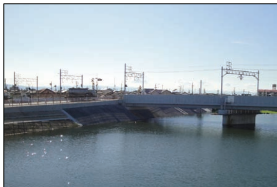
五条川の護岸整備
