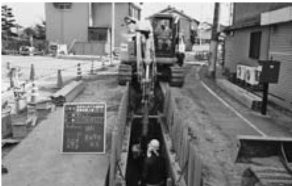
下水道の工事
