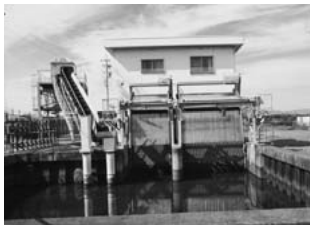
小切戸第二排水機場
