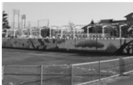
解体予定の美和プール
