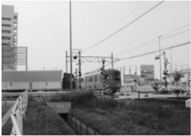
国道302号(名鉄津島線との交差部)
