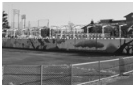
解体予定の美和プール
