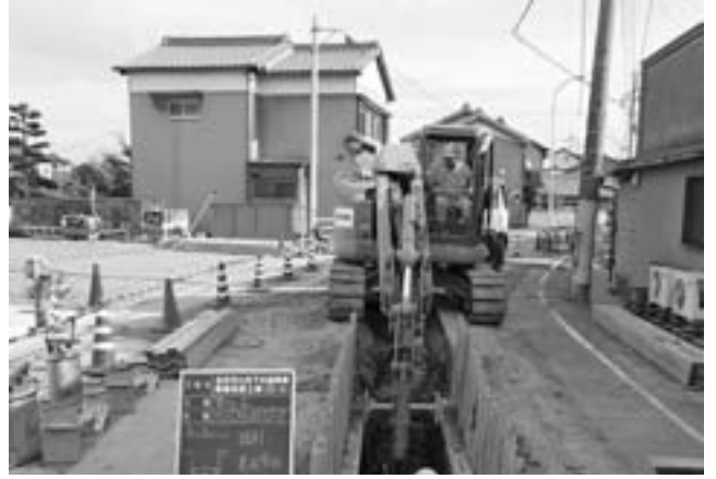
下水道工事の様子
