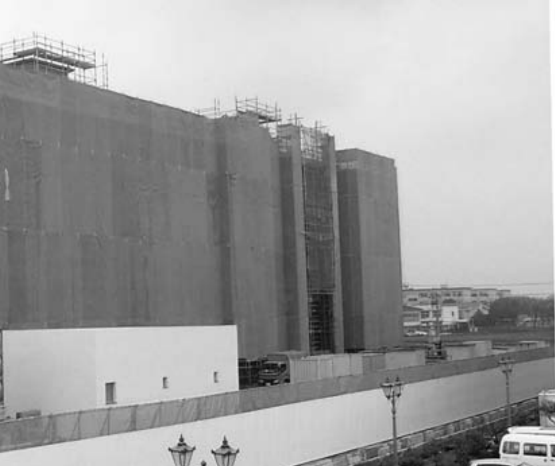
新市民病院建設現場
