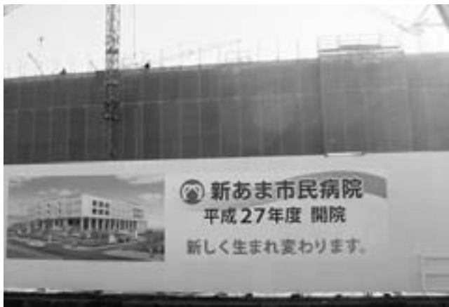
新あま市民病院建設現場
