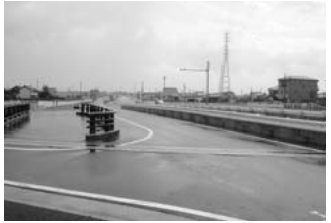
県道名古屋津島線バイパス
