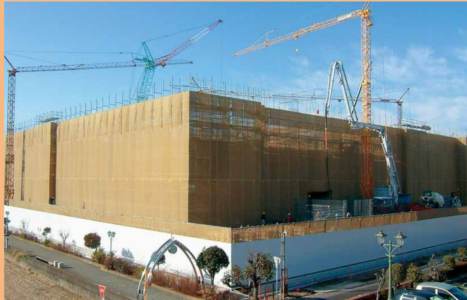
平成 27 年度開院に向けて工事が進む新市民病院
