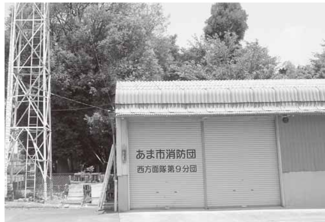
西方面隊第9分団のポンプ小屋
