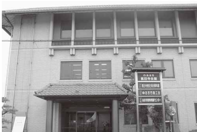
あま市商工会がある甚目寺会館
