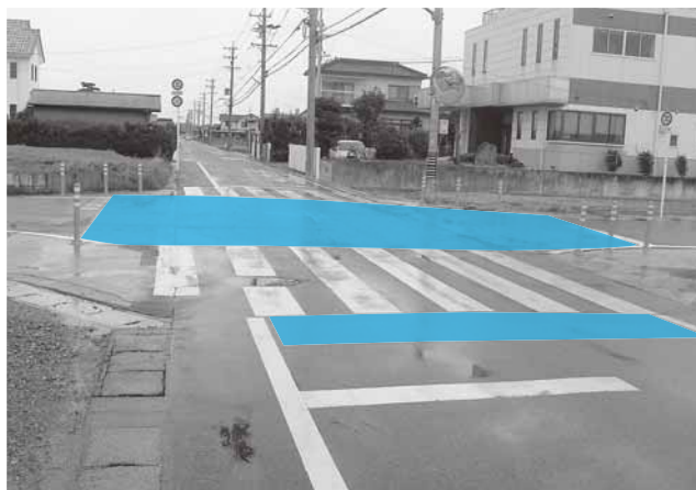
交差点に施されたカラー舗装などの安全対策
