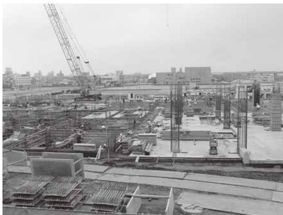
新病院建設現場
