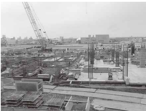
新病院建設現場
