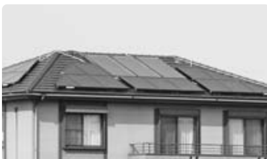
住宅用太陽光発電システム
