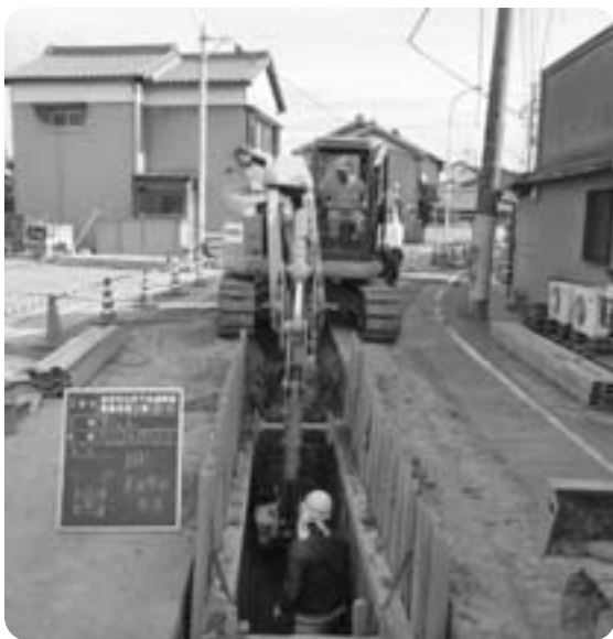
市内で着々と進む公共下水道工事
