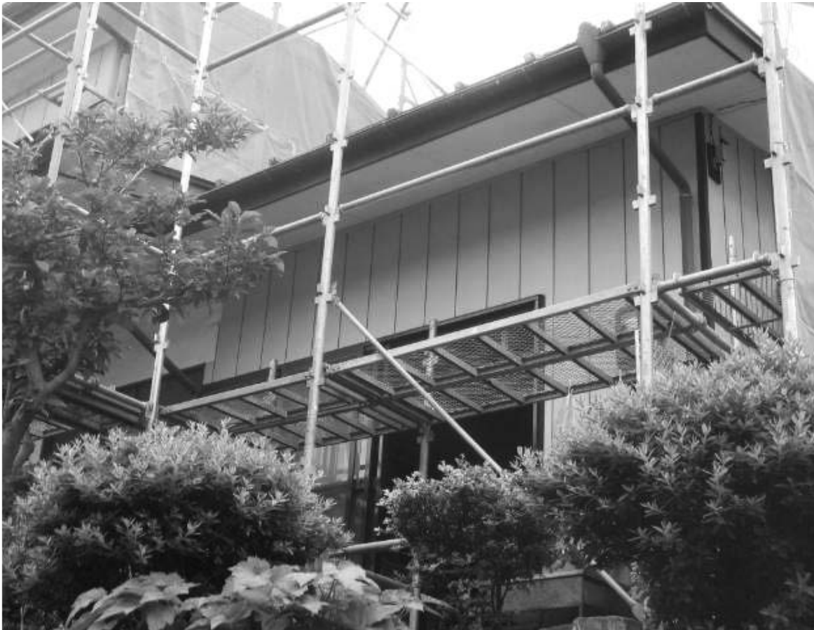
木造住宅の耐震改修補強工事（インターネット上より）
