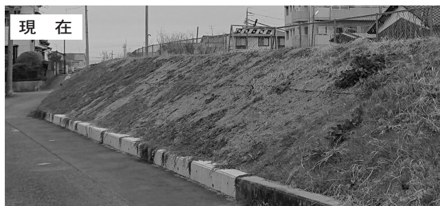
補修工事の終わった土吐川堤防
