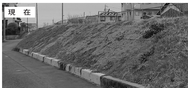
補修工事の終わった土吐川堤防
