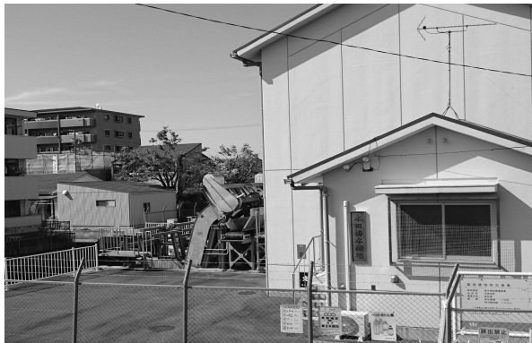
治水の要である木田排水機場は今年度拡張予定です
