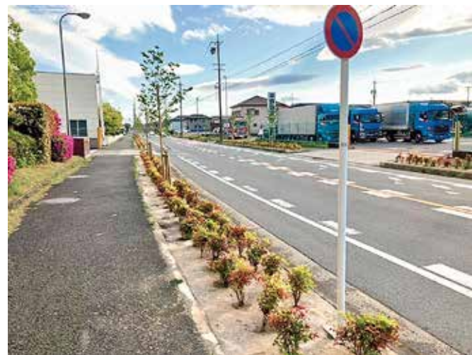
整備された植樹帯(森区)
