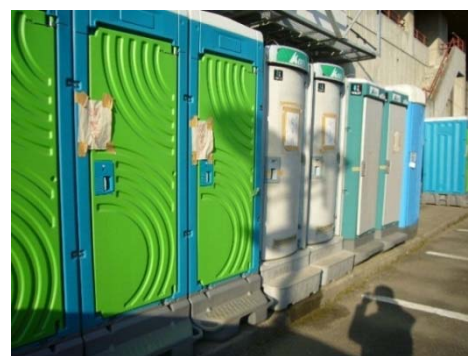
避難所に設置された仮設トイレ(東日本大震災：宮城県多賀城市の総合体育館)
