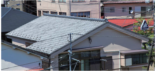
健全な瓦屋根
