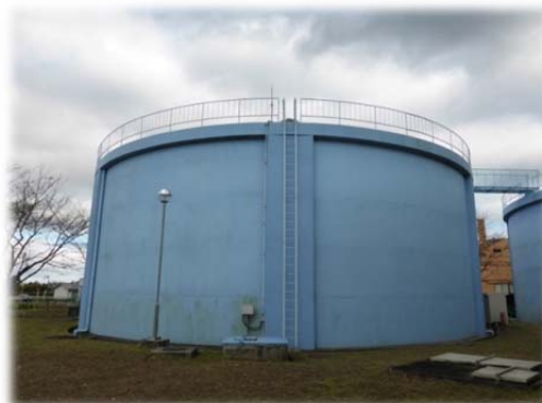
木田上水道配水管理センター配水池
