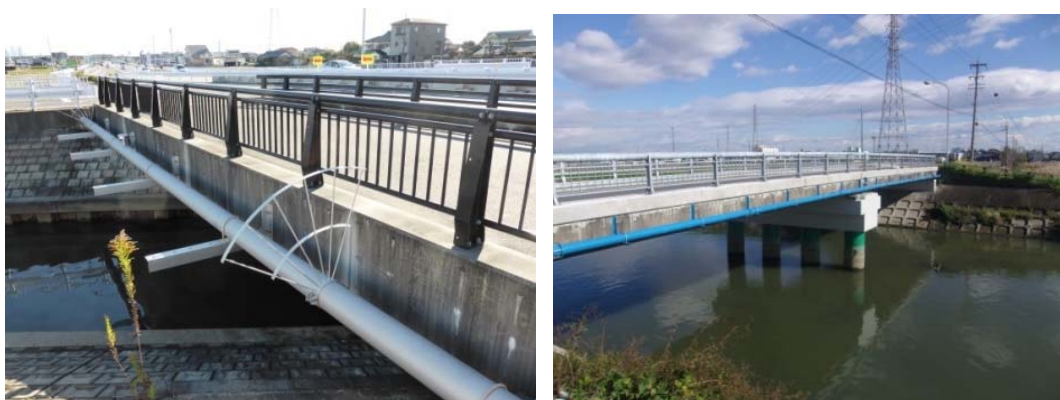
水管橋 (橋梁添架形式)
