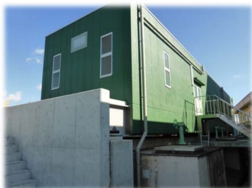
川部上水道配水場第2管理棟
