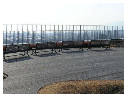
屋上緑化・デッキ
