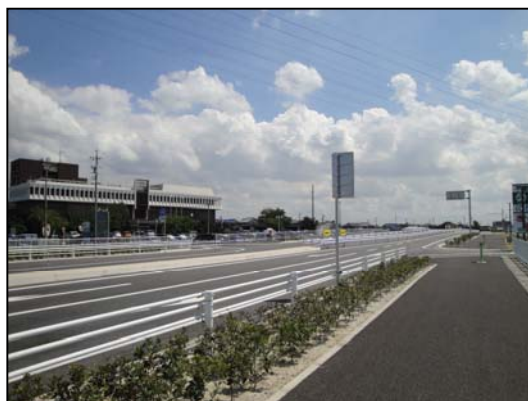
七宝庁舎前を通る県道名古屋津島線バイパス
