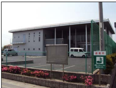
坂牧コミュニティ防災センター
