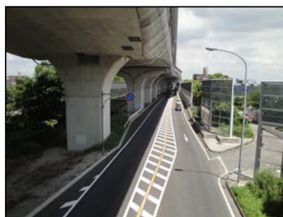
(都)名古屋環状2号線（国道302号）
