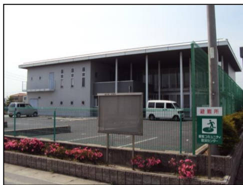
坂牧コミュニティ防災センター
