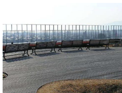
屋上緑化・デッキ
