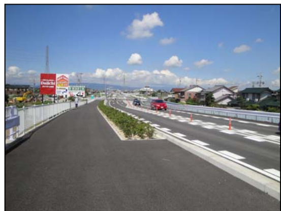
県道名古屋津島線バイパス
