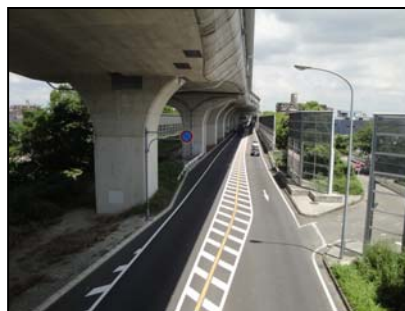
(都)名古屋環状2号線（国道302号）
