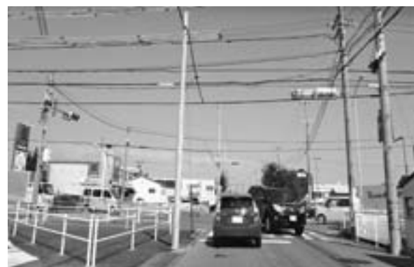
主要地方道あま愛西線坂牧東交差点
