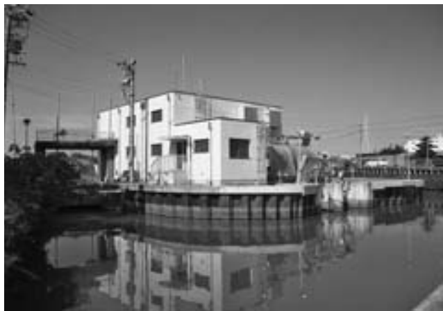
鷹居排水機場
