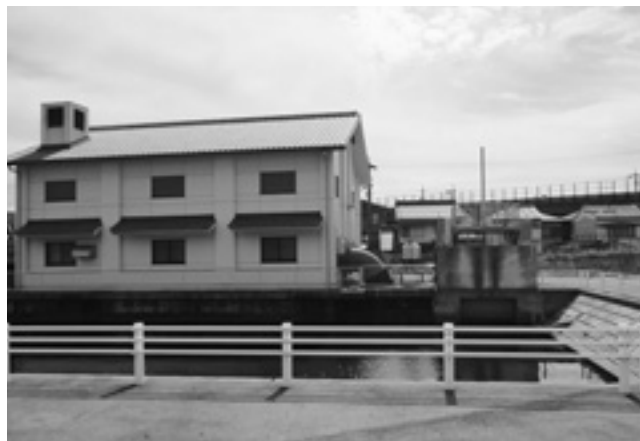
小切戸排水機場
