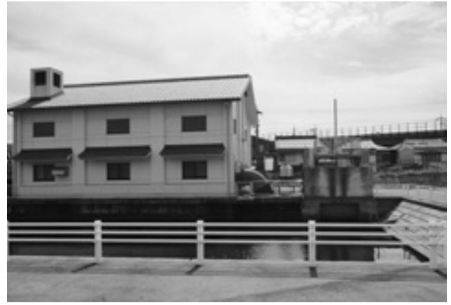
小切戸排水機場
