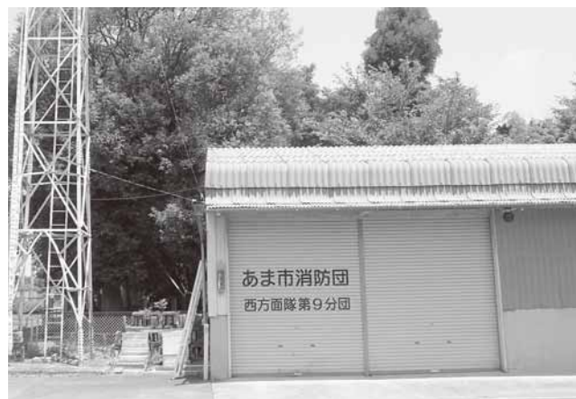
西方面隊第9分団のポンプ小屋
