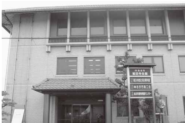
あま市商工会がある甚目寺会館
