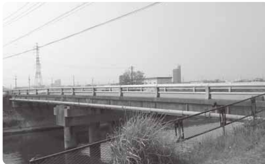
今年度改修される川伊大橋
