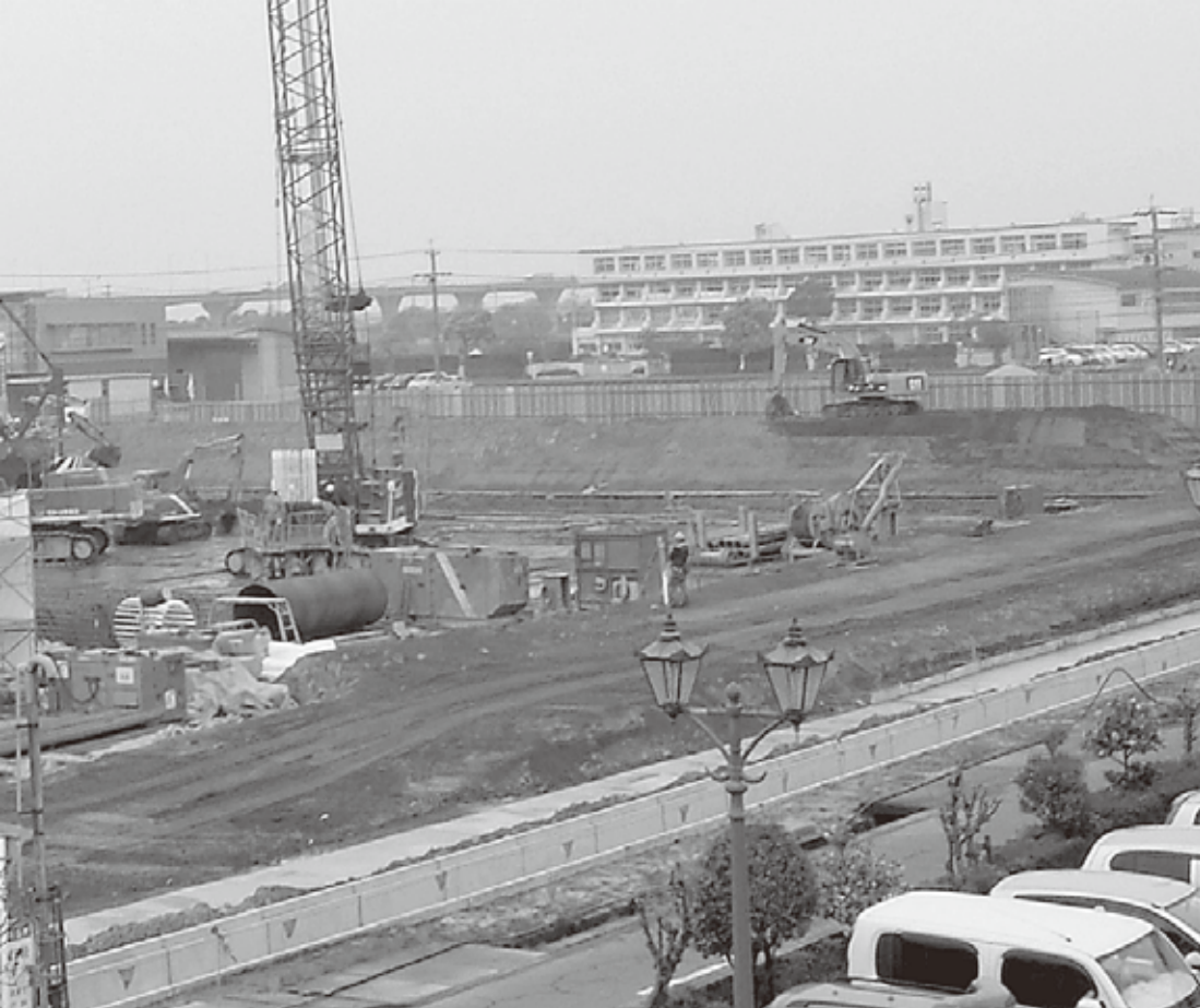
新市民病院建設現場
