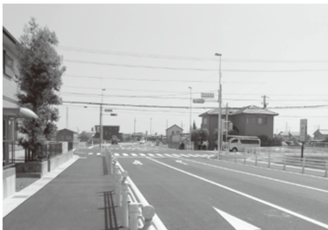
安松鷹居線の新下田橋東交差点
