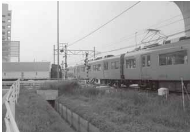
国道302号線、名鉄津島線の踏み切り
