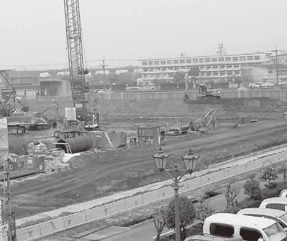
新市民病院建設現場
