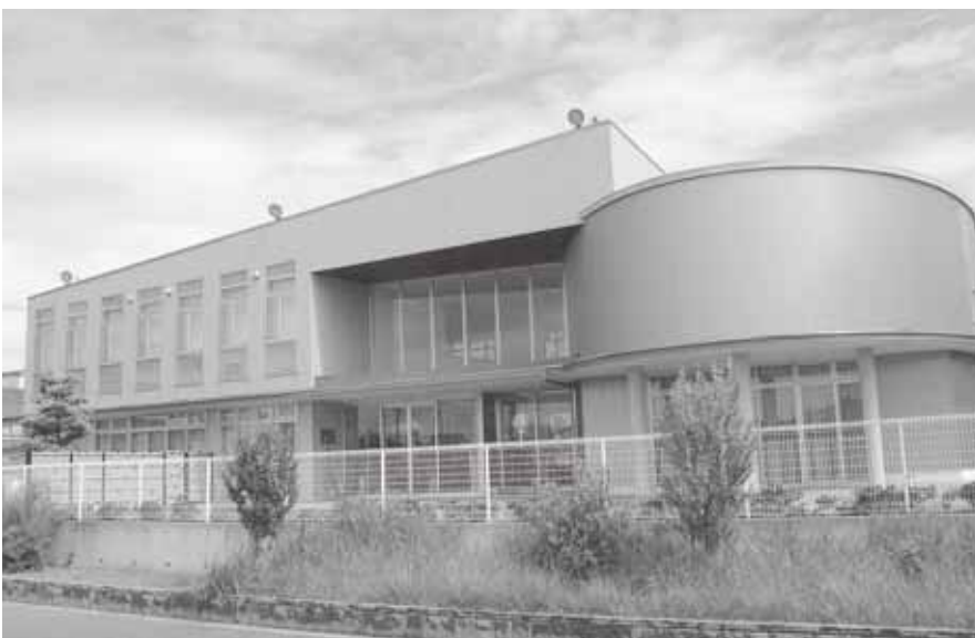
上萱津コミュニティ防災センター
