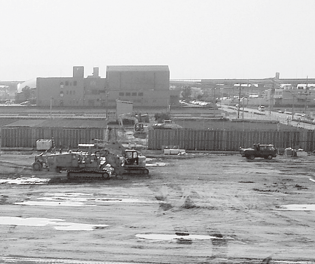
造成工事の始まった、新市民病院建設地
