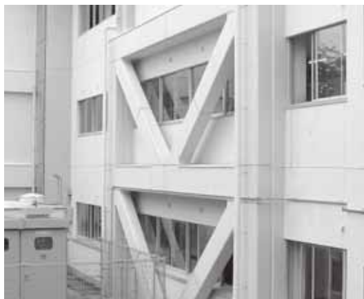
耐震化対策の施された校舎
