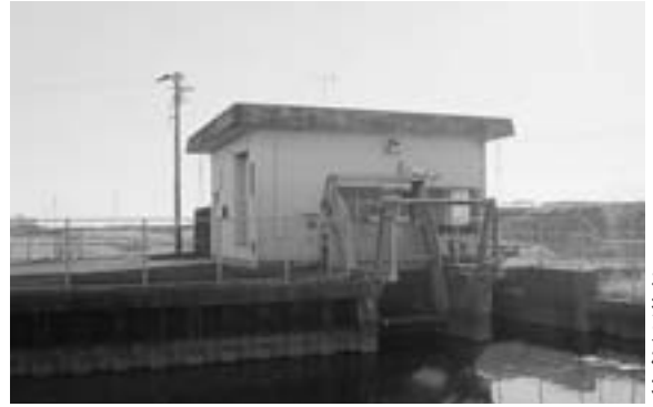
四ヶ村排水機場
