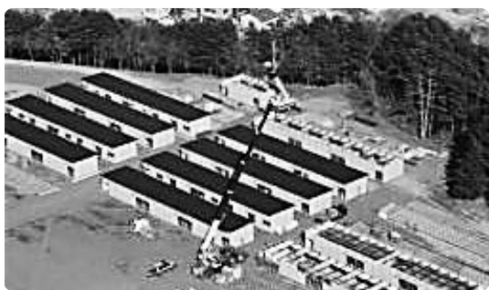
岩手県山田町で建設中の仮設住宅
