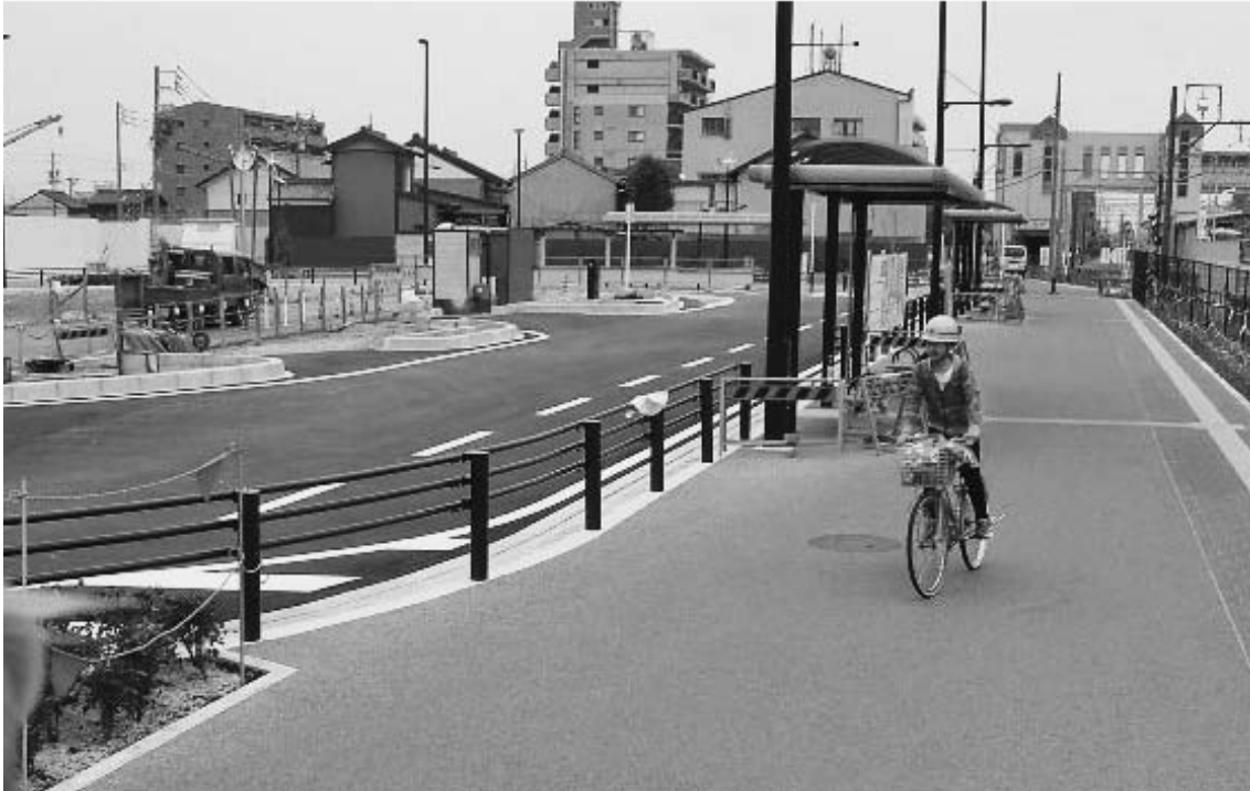
完成もない甚目寺駅北口広場
