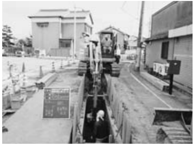
市内で着々と進む公共下水道工事
