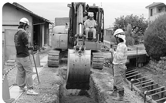
旧美和町地内での下水道工事
