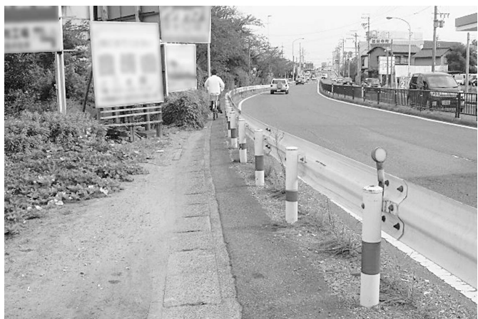
「せまいな～」萱津橋西の歩道
