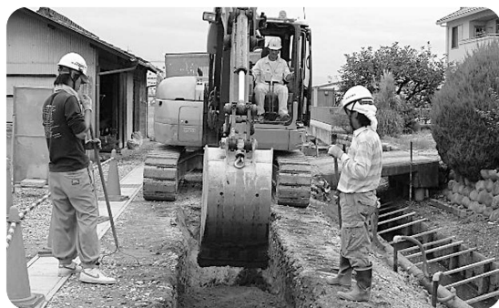
旧美和町地内での下水道工事
