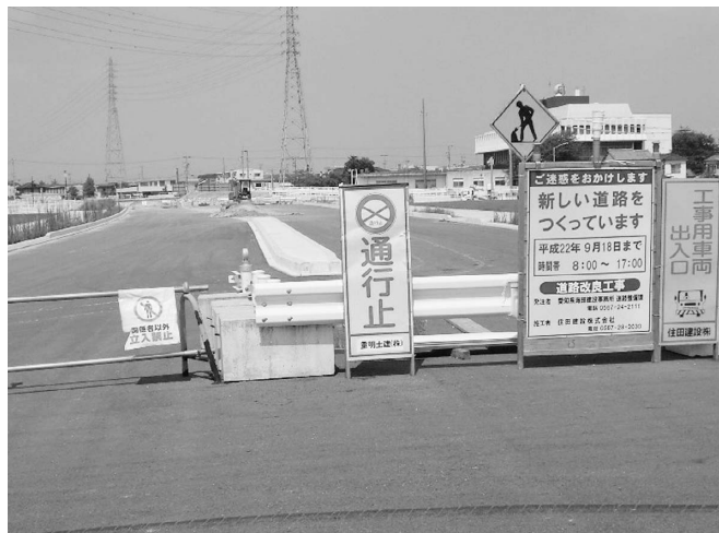
完成が待たれる名古屋津島線バイパス
