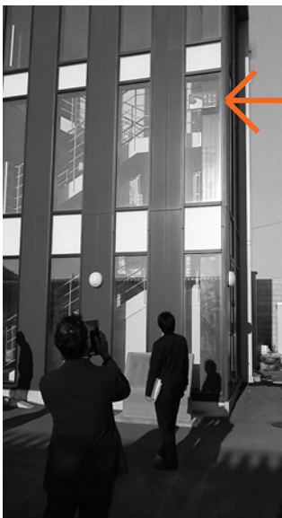
当時、矢印の高さまで津波が押し寄せました。
