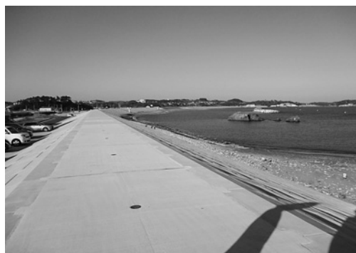
震災後、防潮堤が整備されました。
