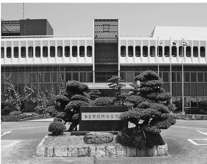
無人化となるため、仮囲い工事を行う七宝庁舎
