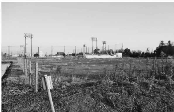
新学校給食センター建設地
