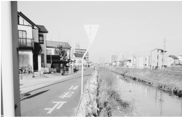
土のう積みが行われた福田川
